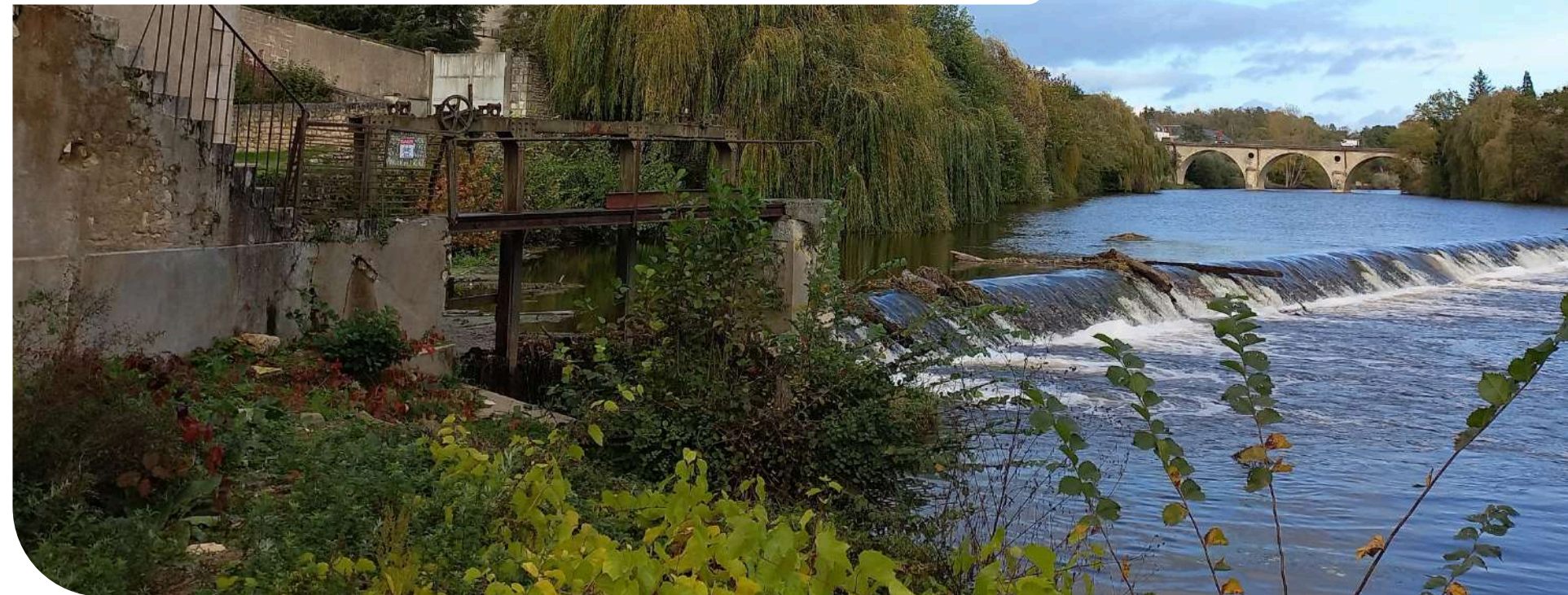
Usine électrique, Saint-Gaultier (36) - photo Aqua
